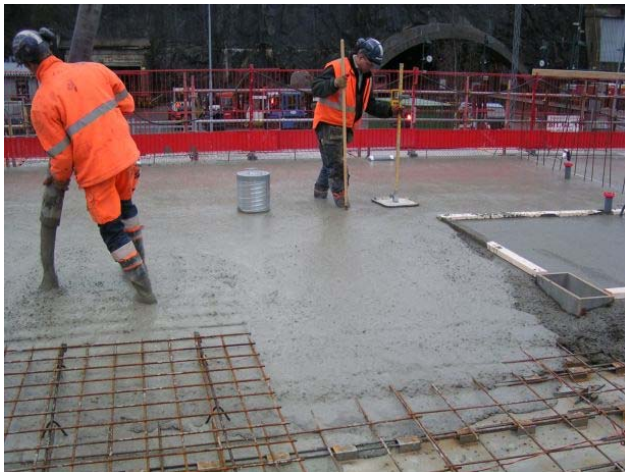
Figur 2 Rationell gjutning med SKB.
