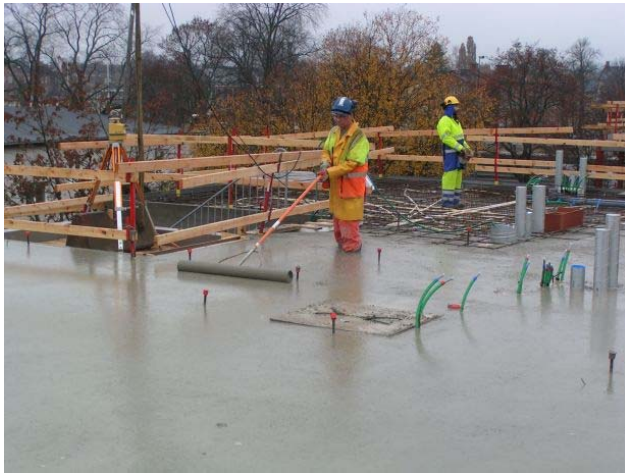
Figur 1 Användande av SKB möjliggör plana ytor direkt efter slodning.
